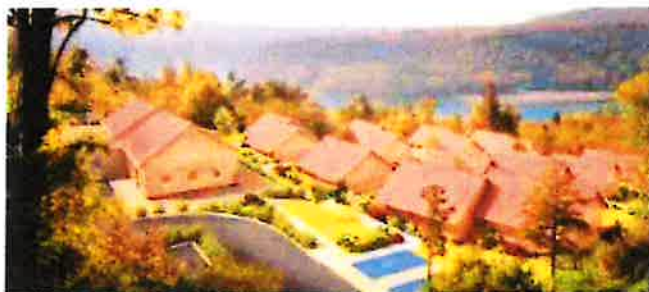
Vue de la façade principale :
